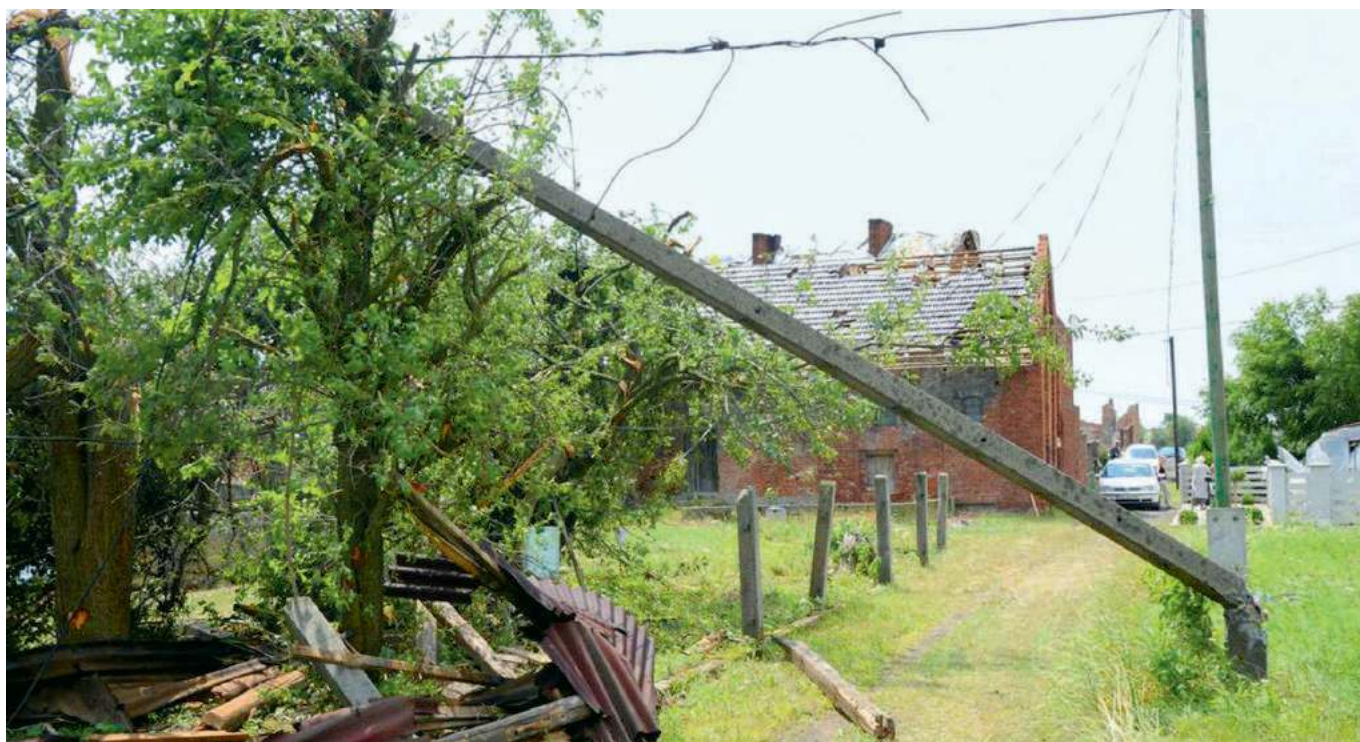
Gwałtowna burza w Landzmierzu (woj. opolskie) zniszczyła też linię energetyczną.
