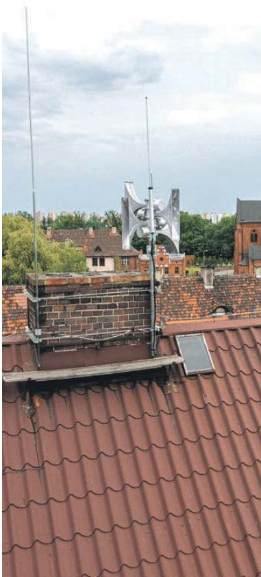
Syrena na dachu SP nr 16
