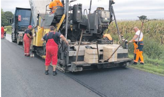
Prace nad nową nawierzchnią
