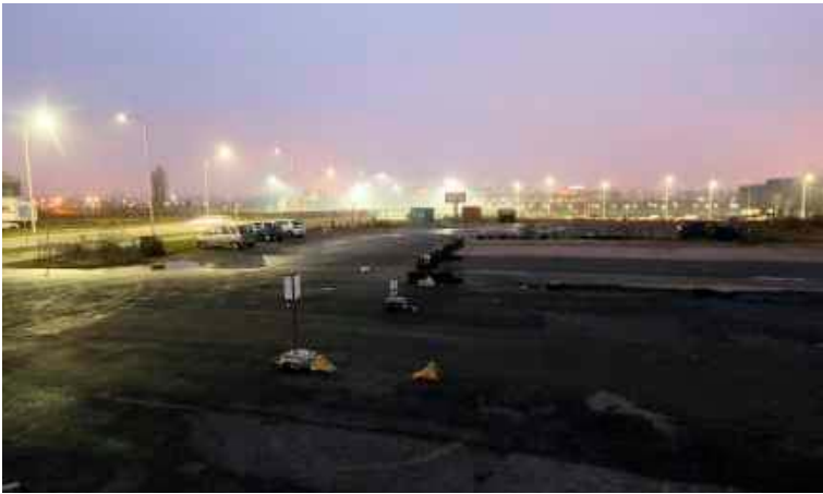
Dwa bloki z mieszkaniami plus powstaną na działce po byłej cukrowni
