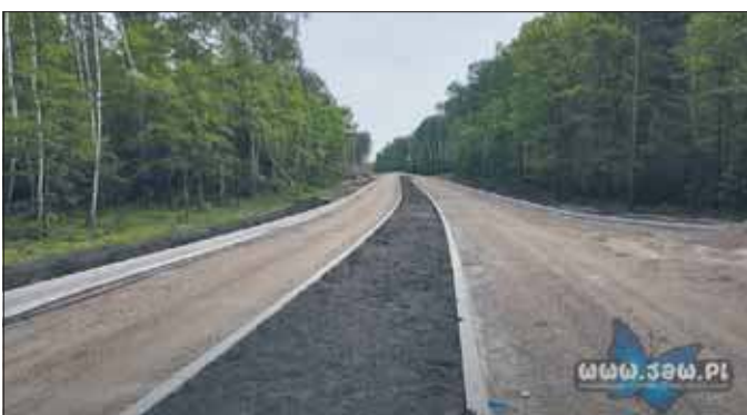
Prace na wysokości Parku Lotników – ulica Nowoszczakowska
