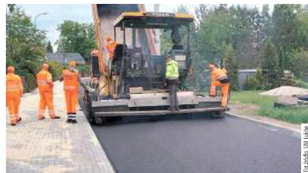
Zakończenie wszystkich prac zaplanowano na 12 czerwca
