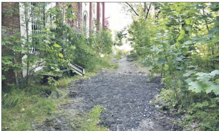
Zasypana studzienka obok ściany byłego zakładu
