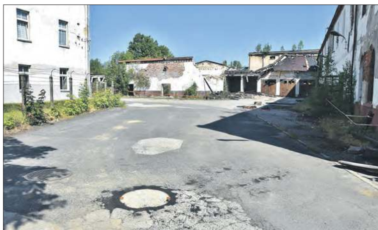
Zabezpieczona betonowym włazem studzienka, a w tle walące się budynki
