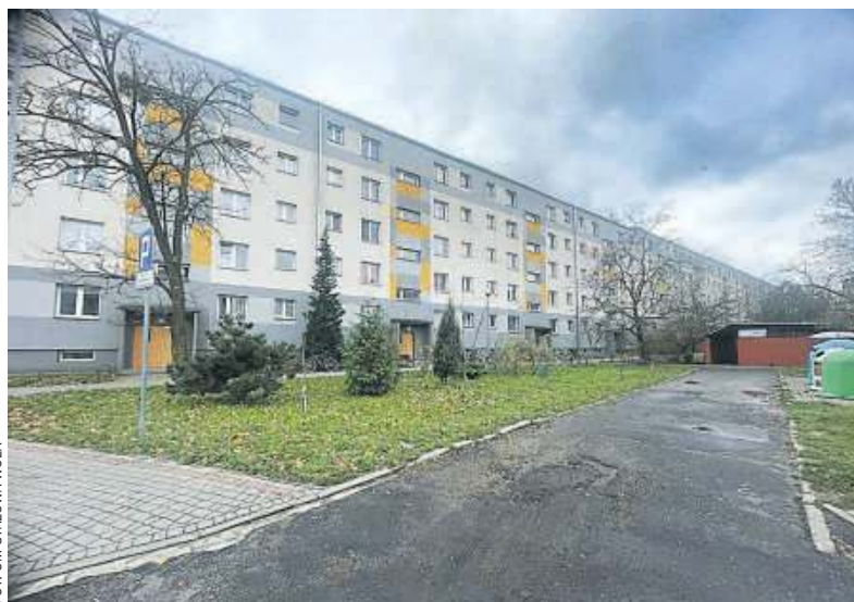
W pierwszym podejściu nie udało się wyłonić wykonawcy rewitalizacji tego terenu
