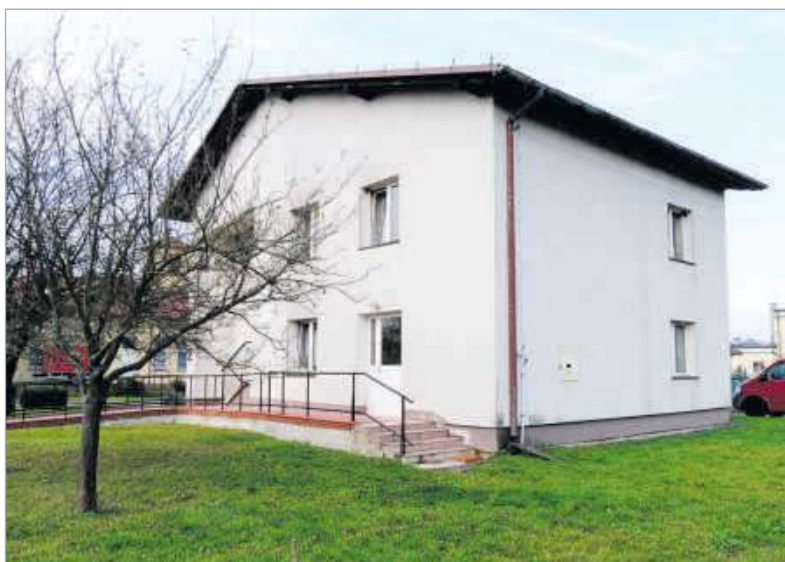
Budynek przy Jaśminowej czeka rozbudowa
