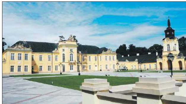
8 sierpnia rezultaty prac wykonawcy oceniał konserwator zabytków. Jego zdaniem dziedziniec to nowa jakość przestrzeni
