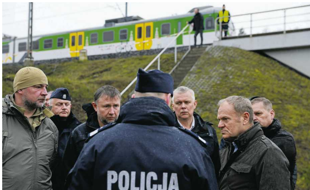
• Na miejscu uszkodzenia torowiska był w poniedziałek rano premier Donald Tusk FOT. PAP/KPRM
