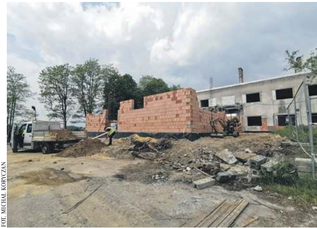
Trwa przebudowa budynku na potrzeby gospodarki komunalnej
