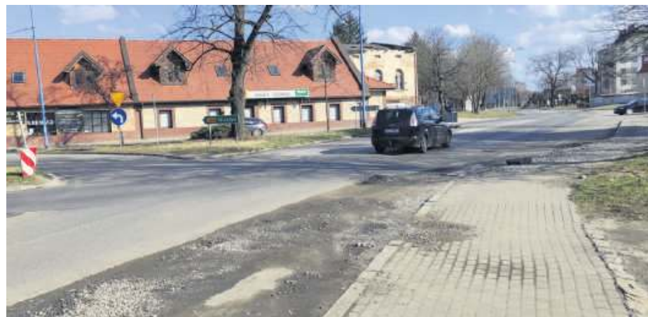
Dalszy etap remontu ulicy Wolności w Strzelinie zakłada budowę ronda u zbiegu ulic Wrocławskiej, Oławskiej i Wolności
