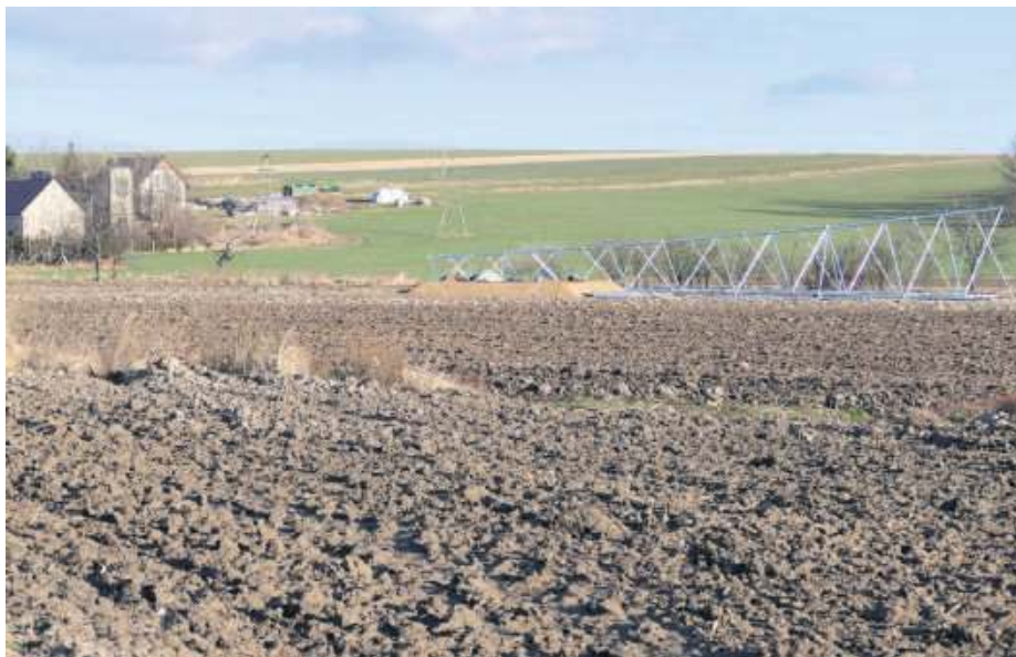
Stacja bazowa stanie pomiędzy Kuropatnikiem a Gościęcicami Górnymi. Wylano już fundamenty pod inwestycję, a w ubiegłym tygodniu przywieziono metalowe elementy masztu
