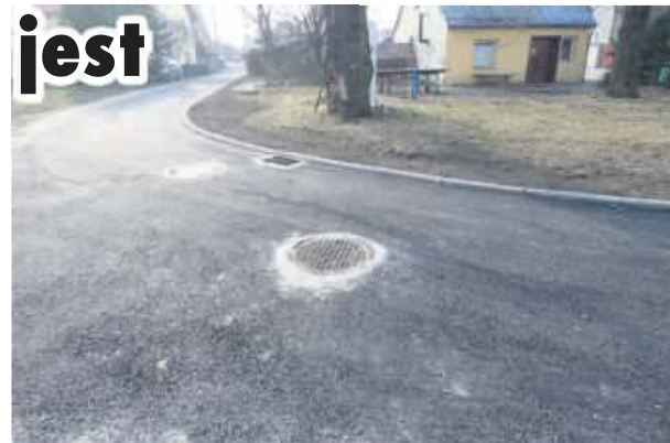
W Gościecicach na remontowanej drodze jest już asfalt
