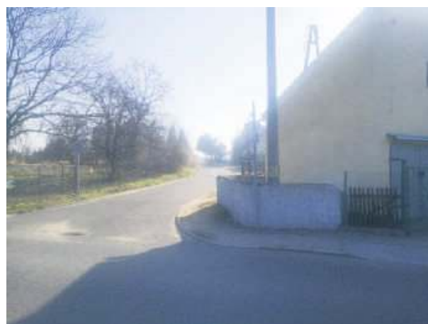
Miedzy innymi na skrzyżowaniu ulic Okrężnej i Ziębickiej oraz Pocztovej i Okrężnej w Przewornie wiatr zniszczył lustra drogowe. Ich brak ogranicza kierowcom widoczność i stwarza zagrożenie w ruchu
