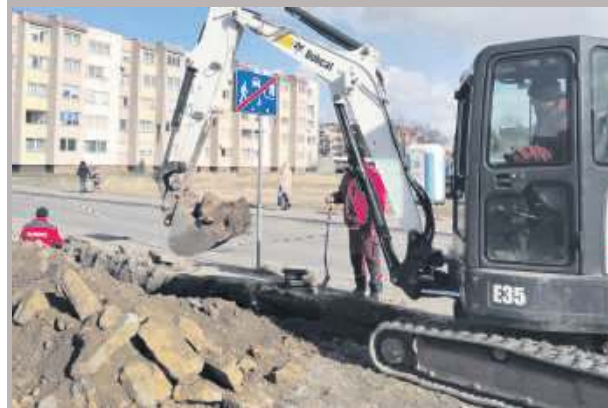
Tak powstawał wykop na kabel energetyczny zasilający ratusz
