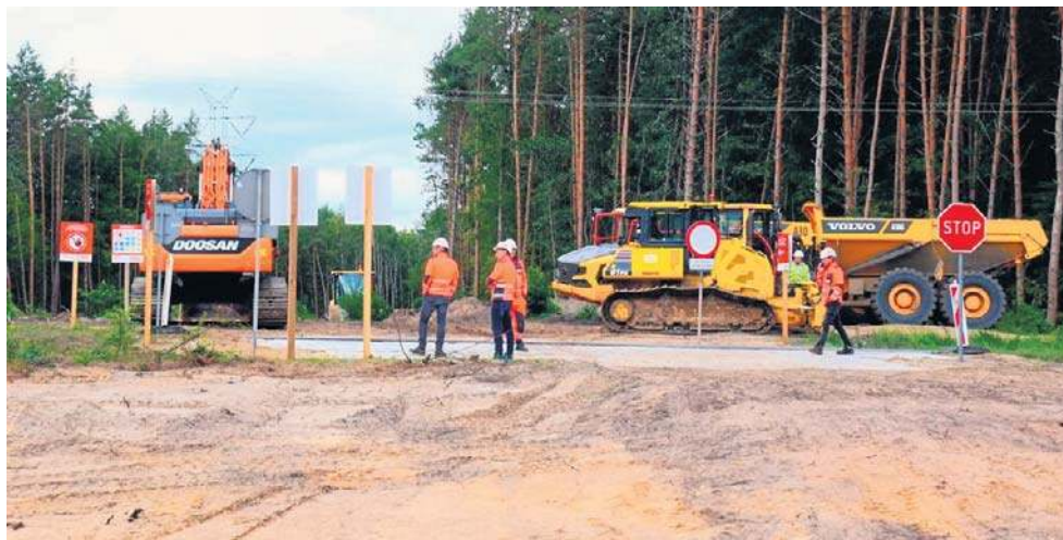
Pierwszy odcinek obwodnicy Polic ma połączyć ulicę Tanowską z Przęsocinem
