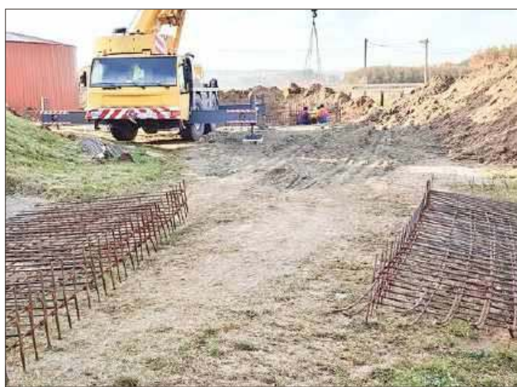
Prace w Brzeźnicy już się rozpoczęły. Fot. UG Dębica.
