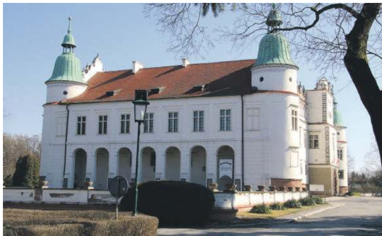
Zamek w Baranowie Sandomierskim to szesnastowieczna perełka architektury renesansowej
