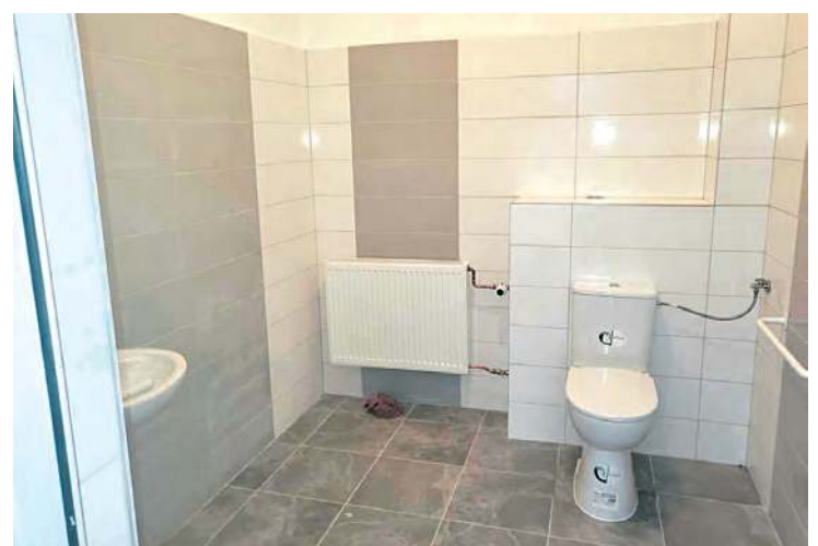
Pomieszczenie sanitarne zyskało nowy blask.
