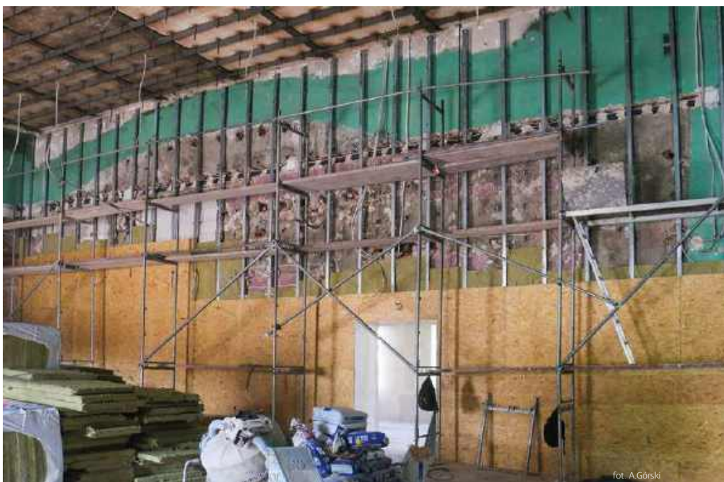
Ściany boczne sali wykonano jako odbijające dźwięki, wykończone płytami OSB na stalowych profilach, między którymi ułożona została wełna mineralna grubości 5 cm.
