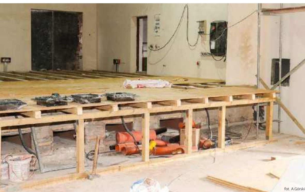
Zaprojektowano też i wykonano nową podłogę sceniczną na konstrukcji legarowej, pokrytej warstwą płyt OSB i deskami sosnowymi o grubości 28 mm.
