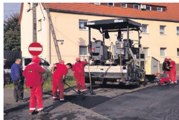
Ostatnie prace na remontowanej ulicy w Przewornie...
