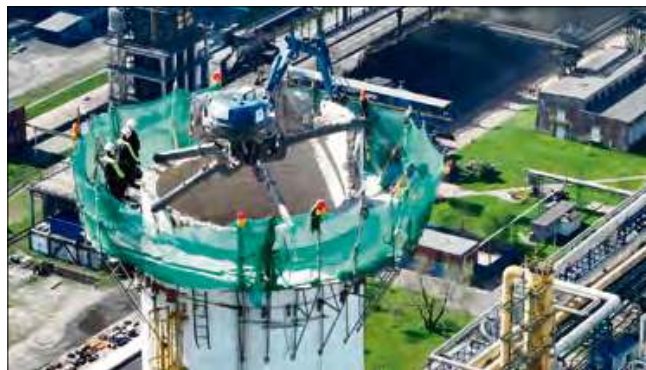
Stara konstrukcja komina jest rozbierana tzw. metodą „zjadania”.
