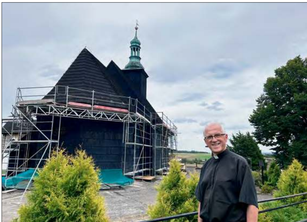
Ksiądz proboszcz Hubert Sklorz opowiada o remoncie zabytkowego kościoła drewnianego w Malni.
