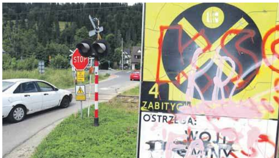
Mieszkańcy Poronina apelują o poprawę bezpieczeństwa na przejeździe z zakopianki do ul. Za Torem.
