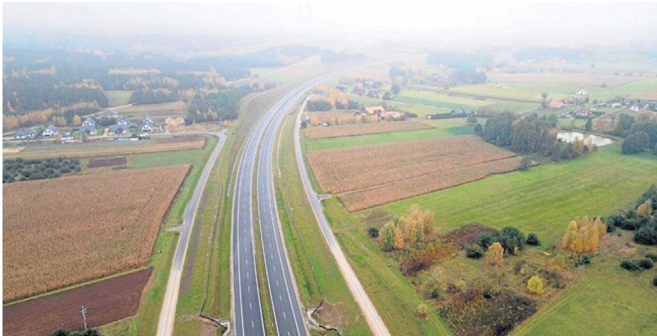
Po ponad 2,5 roku budowy otwarto odcinek S19 Białystok Zachód-Krynice, biegnący przez teren gm. Choroszcz i gm. Dobrzyniewo Duże
