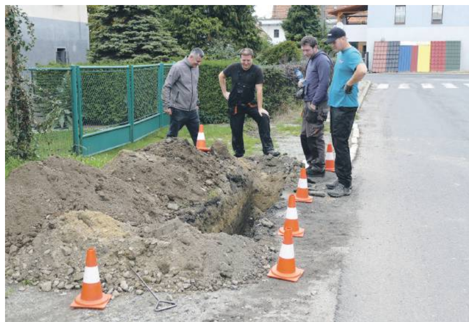
W ubiegłym tygodniu w Przewornie, m.in. przy ul. Ziębickiej, pojawiła się ekipa, instalująca światłowody pod szybki internet. Na zdjęciu od lewej Łukasz Kuźmiński, szef firmy Radio-Net, obok Emil Fatyga, właściciel firmy Multimedia HD
