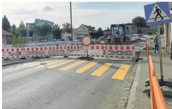
W poniedziałek, 14 października, rozpoczął się kolejny etap remontu strzelińskiego ronda. Wjazd i zjazd w kierunku ul. Wolności został zamknięty
