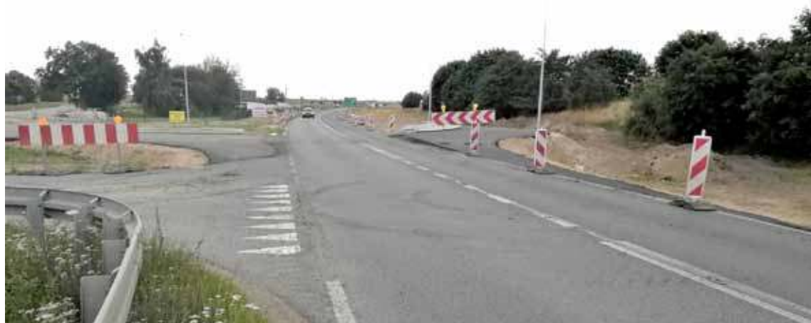
Na ulicy Broniewskiego w okolicy nowo budowanego ronda zostanie wprowadzony ruch wahadłowy
