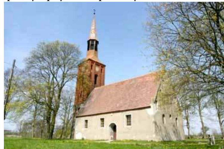
Kościół filialny w Odargowie otrzymał dotację z budżetu gminy na wykonanie projektu remontu dachu kościoła
