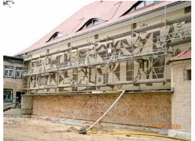
Odnawiany jest mural na zewnętrznej ścianie budynku
