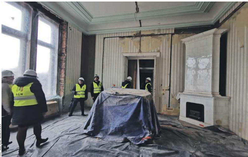
W pałacowych wnętrzach trwają prace
