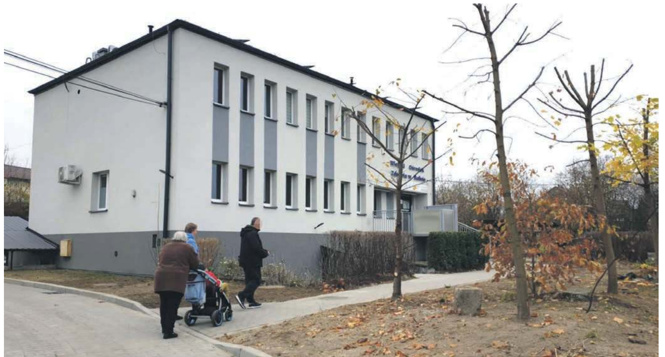
Przychodnia w Balinie, gdzie kończy się budowa drogi dojazdowej i parkingu na zapleczu
