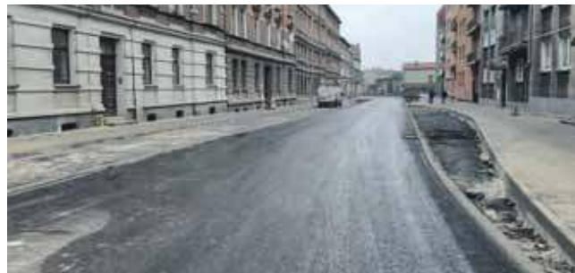
Na ulicy Powstańców Śląskich wylano warstwę bitumiczną, ale to nie koniec
