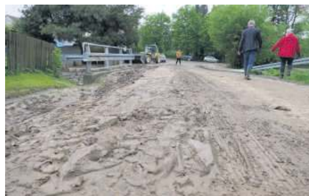
Jeśli wojewoda dolnośląski przeznaczy pieniądze na przebudowę rowu w Zarzycy, to mieszkańcy unikną kolejnych podtopień. Na zdjęciu główna droga w tej miejscowości po gwałtownej ulewie
