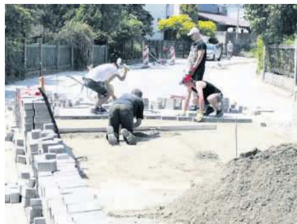
W czerwcu na ulicy Królowej Jadwigi w Strzelinie pracownicy wykonywali roboty poprawkowe. Fot. archiwum Słowa
