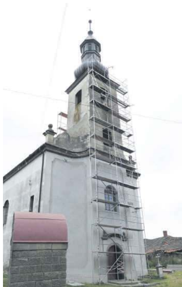
Remont wieży kościoła firma „Ciepły Dom” rozpoczęła w czerwcu od ustawienia rusztowań
