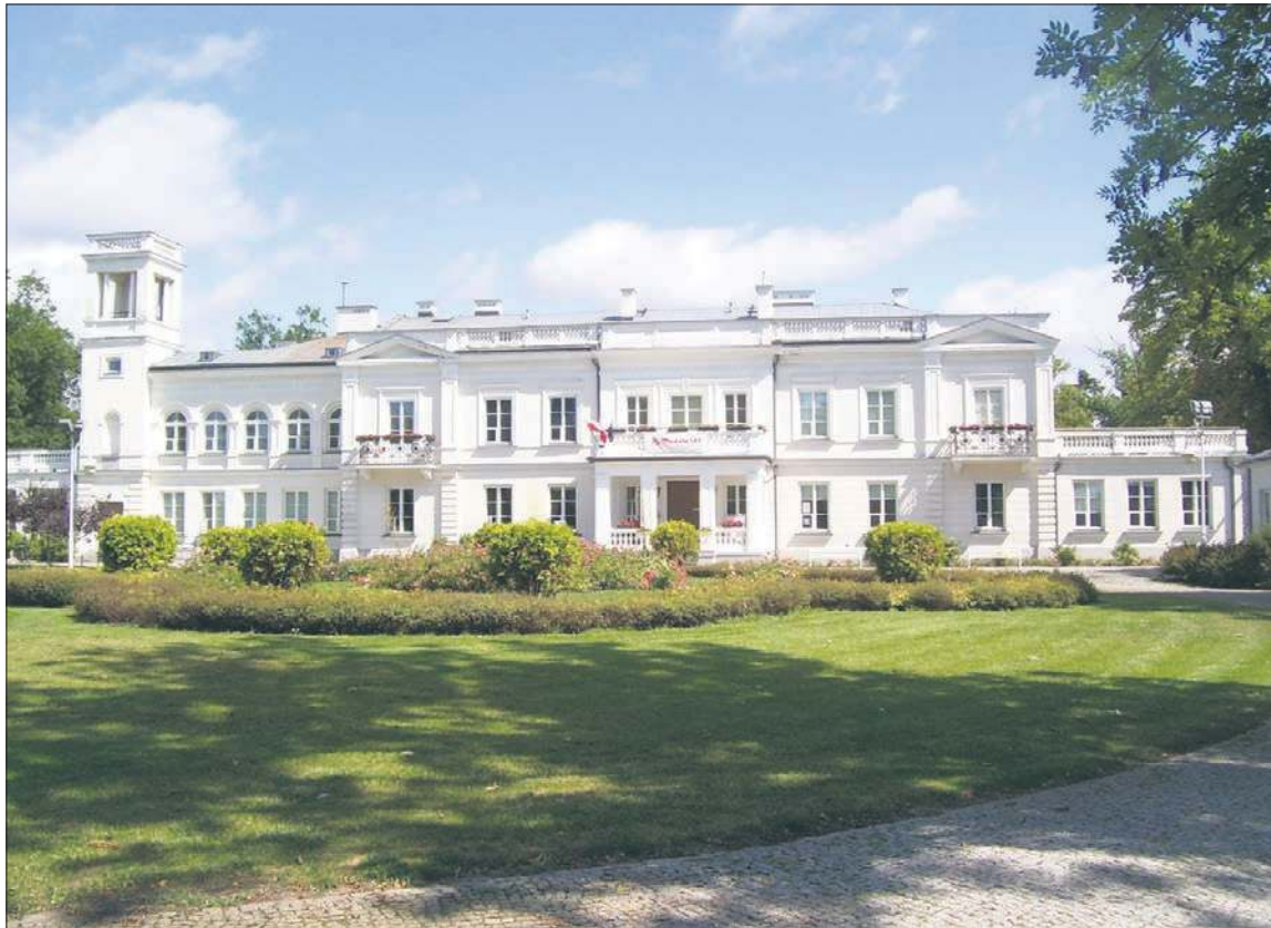
Elewacja frontowa pałacu Prusaków w Sannikach
