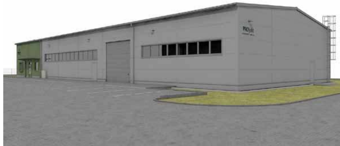
Firma PROjekt M wybuduje w Parku Przemysłowym halę o powierzchni 1000 m 2
