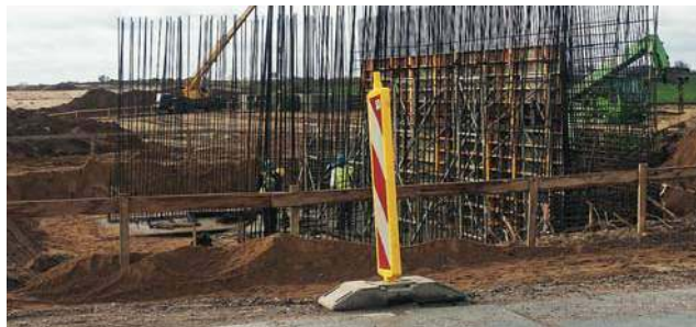
Budowa „siódemki” nabiera tempa
