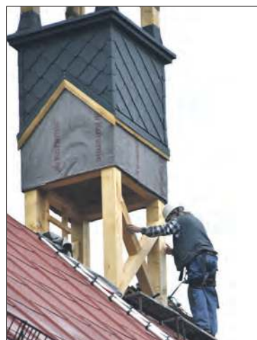
Montaż musi być precyzyjny co do centymetra
