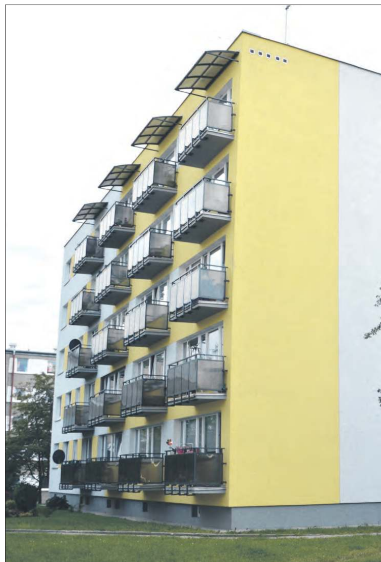
Prace budowlane spółdzielni w 2021 roku obejmą sześć budynków
