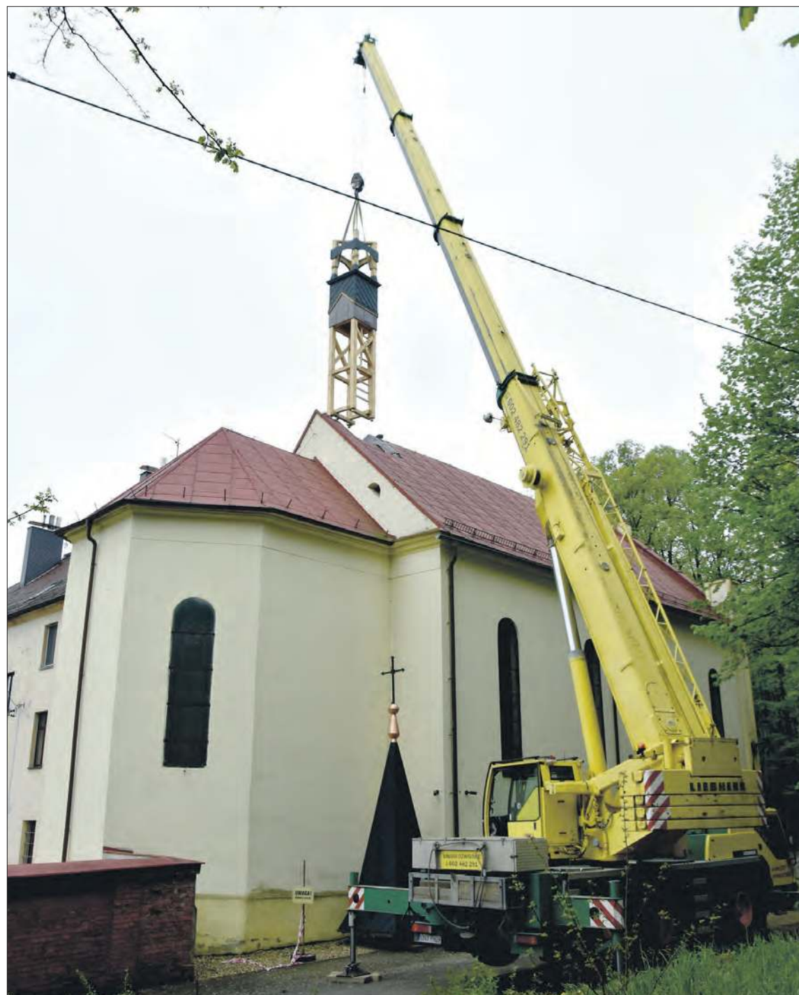
Dźwig osadza główną konstrukcję wieżyczki
