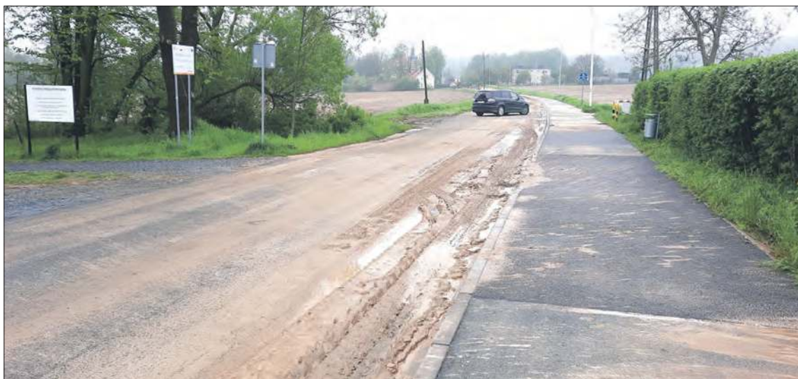
Błotny potok zalał część ul. Poniatowskiego w Prudniku
