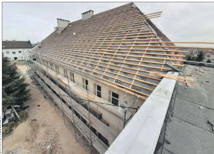
Prace budowlane mają być zakończone do końca sierpnia
