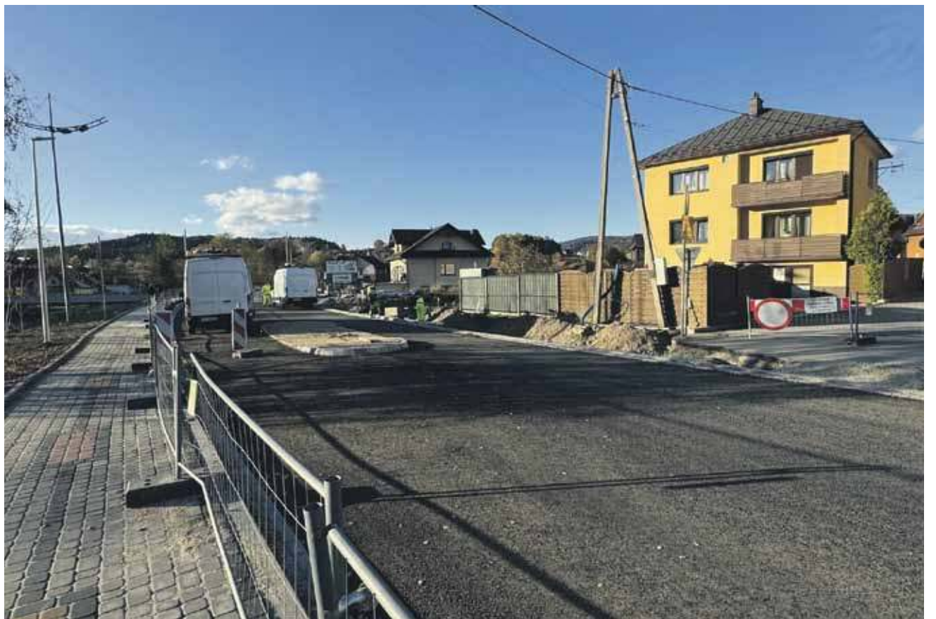
Wyremontowany końcowy odcinek ulicy Jana Pawła II.
