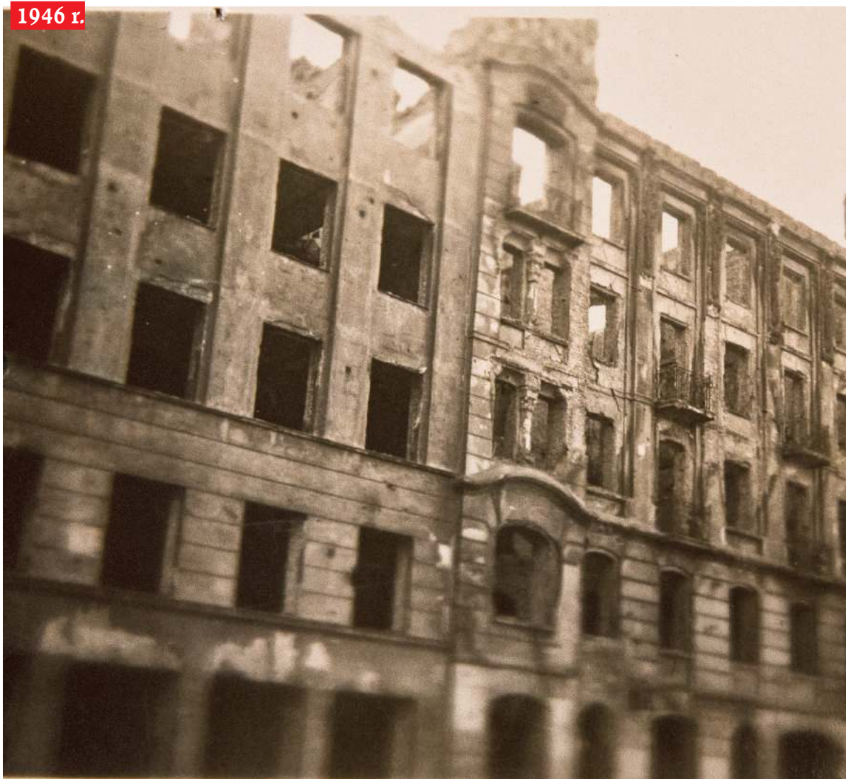
Wypalona kamienica przy ul. Leszno 63 przed zburzeniem. Akta BOS. Zbiory Archiwum Państwowego w Warszawie | fot. Filip Błazejowski/Gazeta Polska
