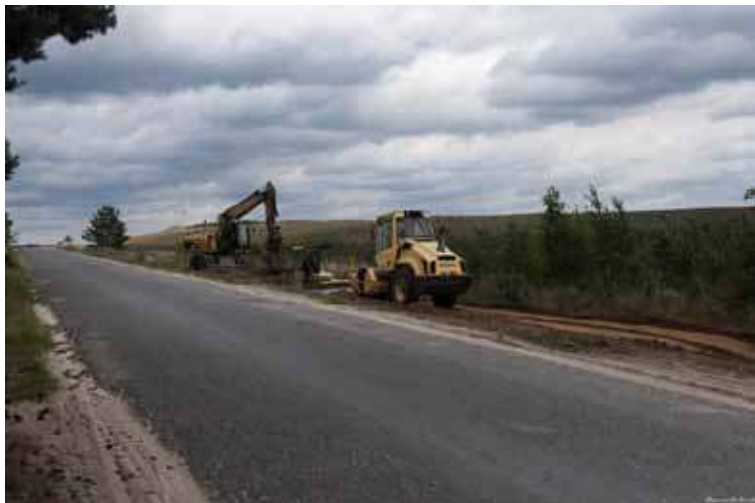
Na odcinku drogi między Storkowem i Ginawą powstaje ścieżka rowerowa
