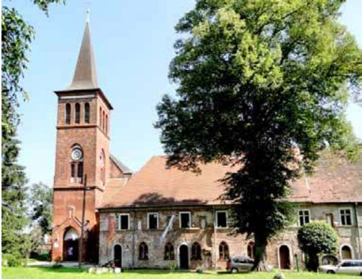
Prace naprawcze konstrukcji dachu i stropu poddasza przejdzie klasztor pocysterski w Marianowie
