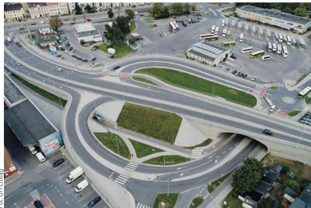
Drogi dojazdowe i wiadukt na Zatorze w Elblągu
