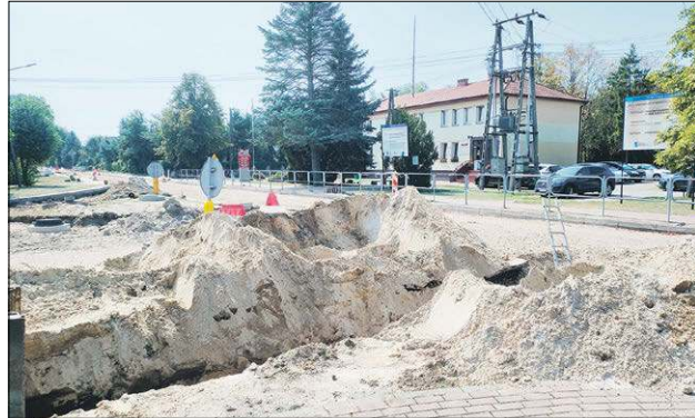
Trwają prace przy budowie kanalizacji w Drelowie
