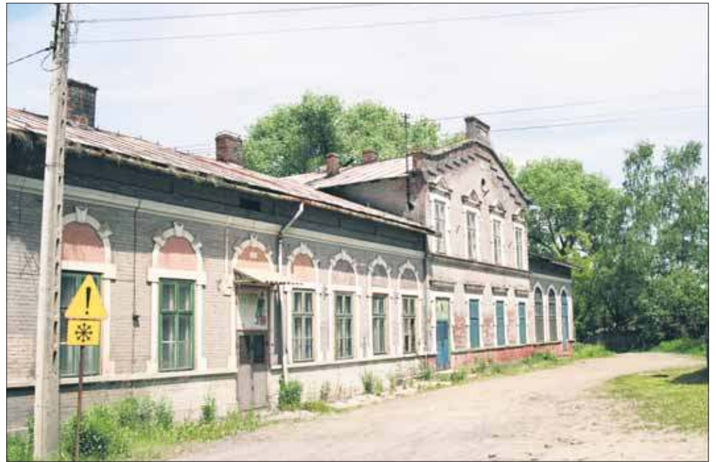
W budynku Poczekany jako ostatnia funkcjonowała „Baryłka”
