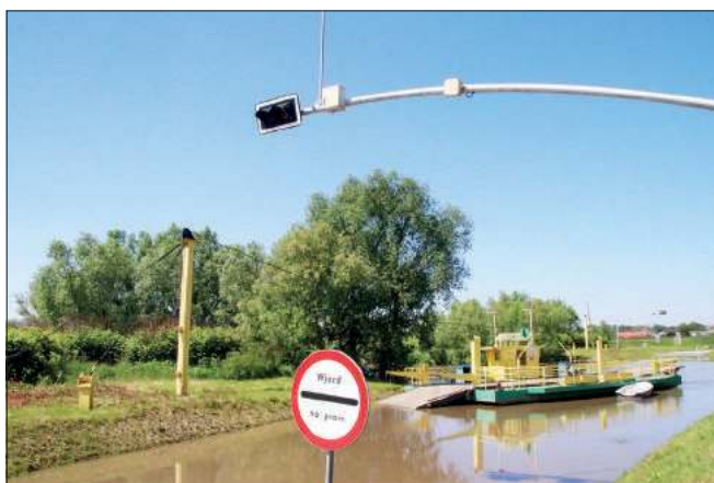
■ Obecnie gminy łączy przeprawa promowa, która nie zawsze jest czynna. W niedalekiej przyszłości ma stanąć most, który na powrót połączy dwa samorządy powiatu raciborskiego. Wybudowany zostanie jednak w innym miejscu
