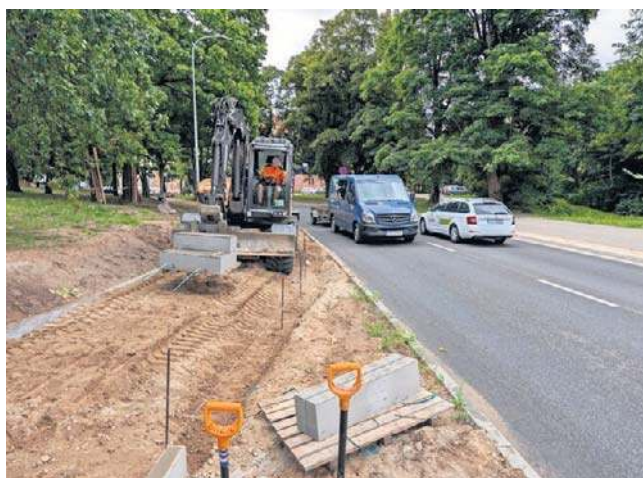
Trwają prace ziemne na ulicy Kaszubskiej
