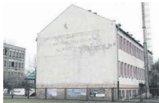
Gmina nie otrzymała dofinansowania na przebudowę budynku po byłym Banku Spółdzielczym przy ulicy Pocztowej w Wiązowie
