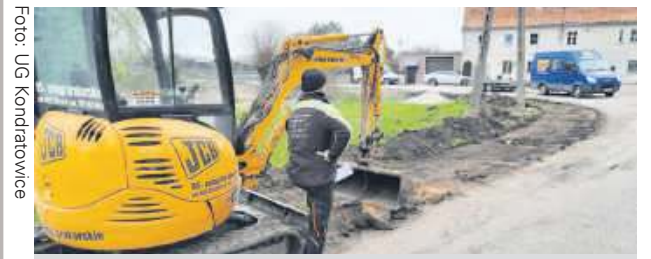
Koszt budowy chodnika w Zarzycy to 22 tys. zł
