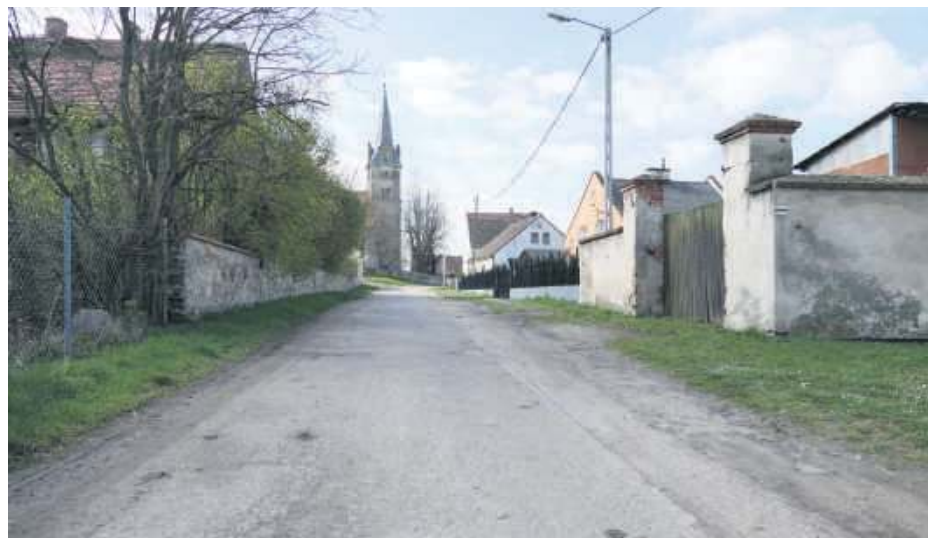
W budżecie gminy Wiązów na 2021 rok zarezerwowano środki na przebudowę drogi w Wawrzyszowie
