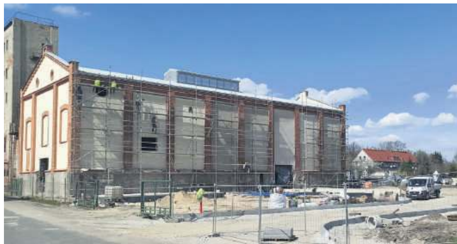
„Cukrownia Strzelin” przystąpiła do realizowania zadań inwestycyjnych. Na zdjęciu remont magazynu, przed którym mają stanąć zbiorniki
