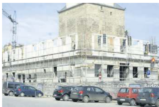
Strop z belkami nad parterem pochłonął prawie 180 m3 betonu czyli około 450 ton
