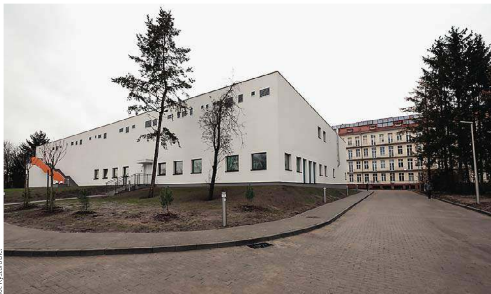
Budowa nowego bloku operacyjnego przy ul. Komeńskiego rozpoczęła się w 2021 roku i trwała prawie trzy lata
