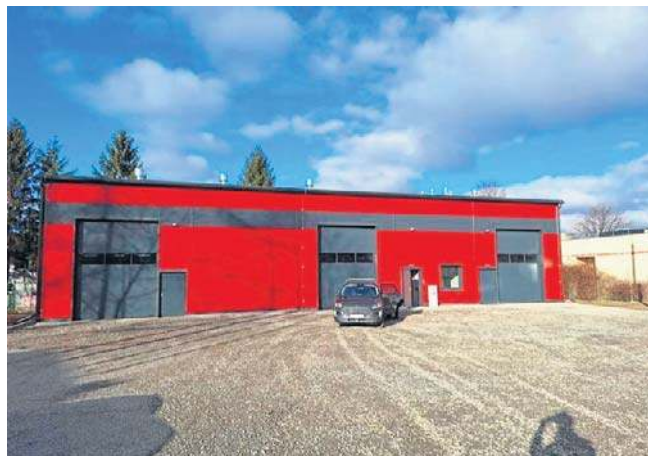
Powiatowy Magazyn Zasobów Ochrony Ludności kosztował 2,9 mln zł. To pierwszy taki obiekt na Dolnym Śląsku
