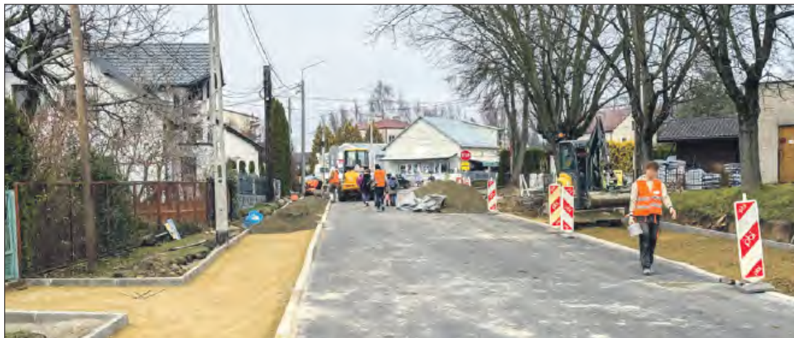
■ Remont drogi ruszył w połowie listopada. Mieszkańcy czekają na nową nawierzchnię, ale teraz wielu rodziców martwi się o bezpieczeństwo swoich pociech
