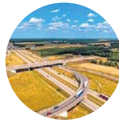
FOT. MAT. GDDKIA
