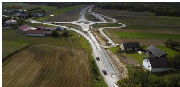
Początek obwodnicy. Rondo w miejscowości Kielczyna
