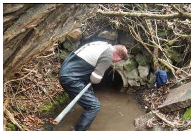
Przepust został udrożniony.
