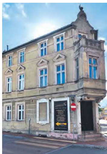
W kamienicy przy ul. Chojnickiej wykonane zostaną najpilniejsze prace, by zadbać o jej dobry stan techniczny.
