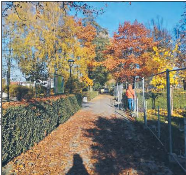
➤ Zakończenie tego etapu inwestycji zostało zaplanowane na koniec kwietnia przyszłego roku. Część parku została wyłączona z użytkowania
