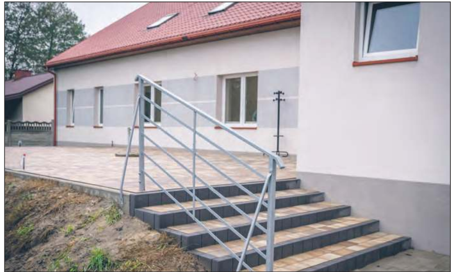
Zakończyły się roboty budowlane w świetlicy wiejskiej w Uścieńcu. Od ubiegłego roku trwała realizacja III etapu przebudowy, rozbudowy i nadbudowy budynku świetlicy wiejskiej w Uścieńcu. Całkowity koszt robót zamknął się kwotą 95.489 zł. Wykonawcą zadania była firma Fron-Instal Sylwester Fronczyk. Operacja była współfinansowana ze środków Unii Europejskiej. Wartość dofinansowania wyniosła 57.743 zł. W tym roku rozpoczął się kolejny (IV) etap robót. Wykonano m.in.: podłogi, schody, montaż drzwi wewnętrznych, grzejników, malowanie pomieszczeń. Rozbudowa świetlicy w Uścieńcu to przykład inwestycji realizowanej etapami. Pierwszy etap zrealizowano w roku 2018. Była to rozbudowa budynku i zagospodarowanie części pomieszczeń na parterze. W kolejnych latach budynek był sukcesywnie wykańczany. Wykonano też prace przy ogrodzeniu i zagospodarowaniu terenu świetlicy.
