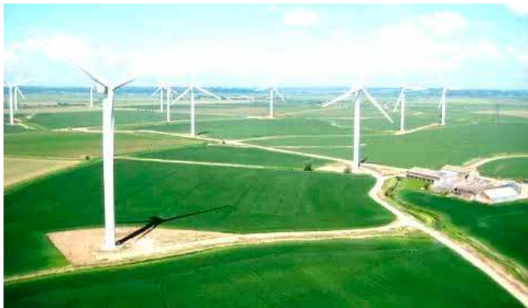
W założeniu firmy Green Future budowa wiatraków to okres od 3 do 4 lat
