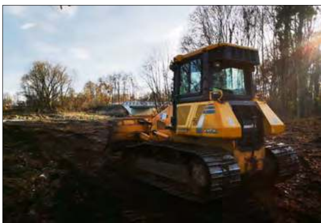
W poniedziałek, 25 listopada, na jednym z brzegów Osobłogi przy ul. Kozielskiej w Krapkowicach rozpoczęły się prace budowlane wyczekiwanej, tymczasowej przeprawy.
