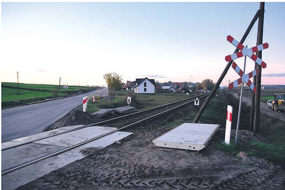
Trwają prace na ul. Świeckiej. Nie rozwiązano jednak jeszcze sprawy przejazdu kolejowego.
